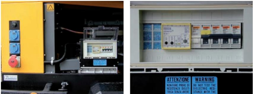
Abb. 11: Ersatzstromerzeuger mit Isolationsüberwachungs- und Abschalteinrichtung
