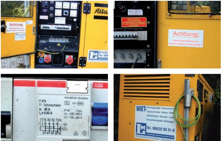
Abb. 3: Ersatzstromerzeuger mit Fehlerstromschutzeinrichtung und Erdspieß
