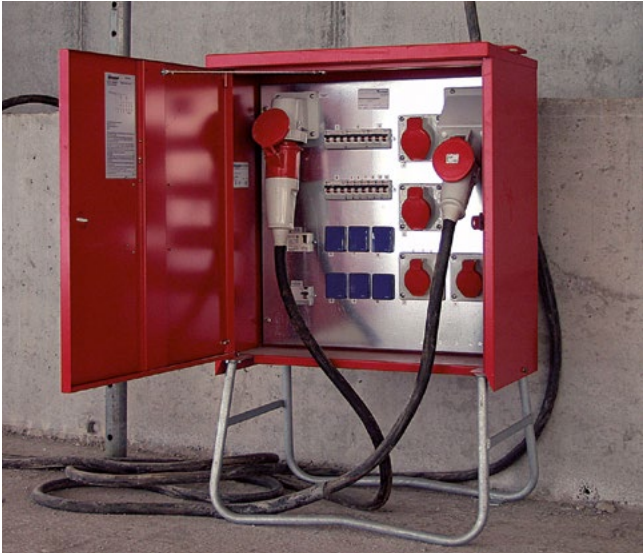
Bild 5-27: Baustromverteiler
