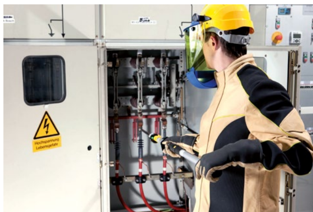
Bild 5-16: Feststellen der Spannungsfreiheit in einem Schaltfeld
