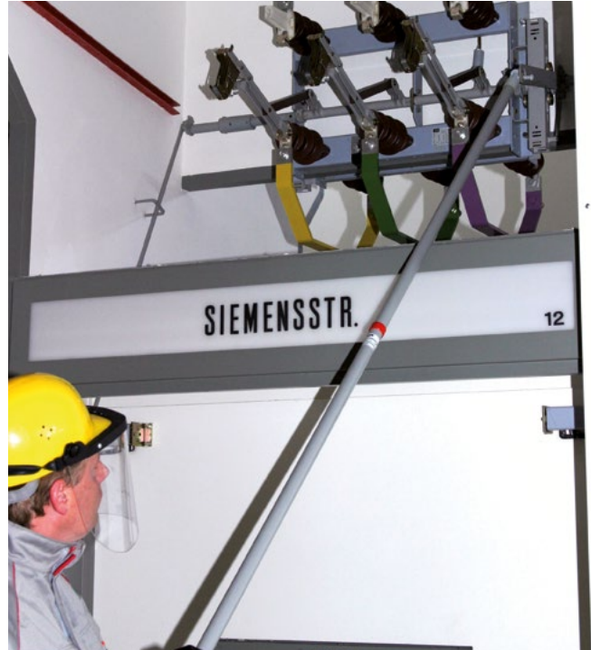
Bild 5-10: Elektrofachkraft beim Öffnen eines Hochspannungstrenners
