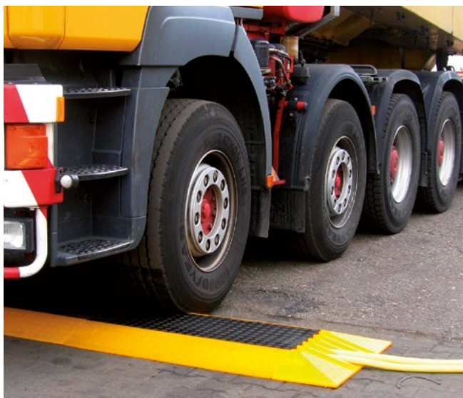
Bild 5-28: Schutz von Baustellenkabeln auf Verkehrswegen
