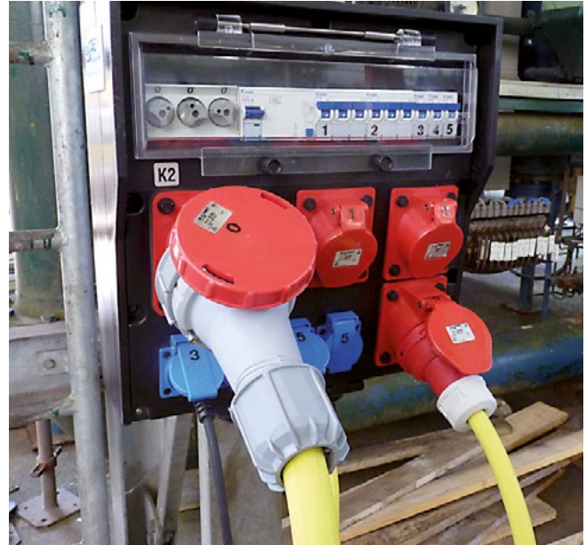
Bild 5-32: Steckvorrichtungen für erschwerte Bedingungen
