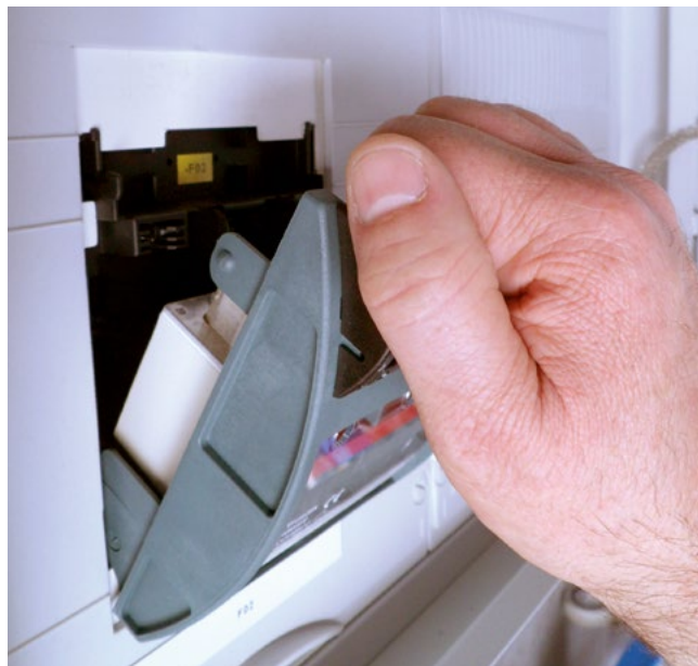
Bild 5-34: NH-Sicherungslasttrennschalter
