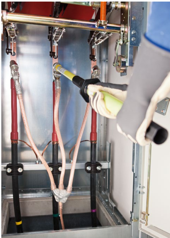
Bild 5-18: Erden und Kurzschließen nur mit kurzschlussstromfester Leitungsgarnitur
