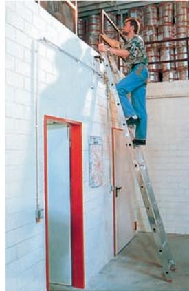
Bild 41: Eingehakte Anlegeleiter zum Übersteigen auf erhöhte Flächen mit Geländer als Haltemöglichkeit
