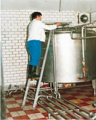
Bild 31: Leiter mit Einhängenvorrichtung am Behälter
