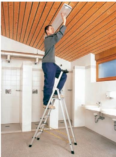
Bild 43: Sicherer Stand auf der Stehtleiter mit Plattform
